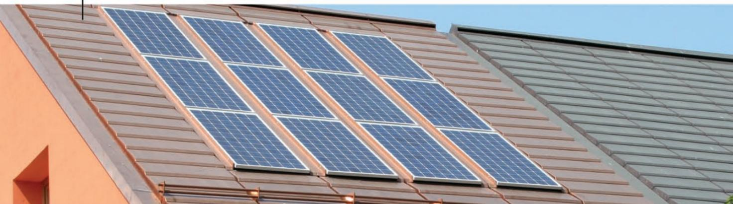
La sinergia tra MAZZONETTO e SOLON, ha sviluppato il sistema **graff-energy** che permette di installare moduli fotovoltaici rigidi in silicio cristallino su coperture in metallo realizzate con la tecnica della doppia aggraffatura.
